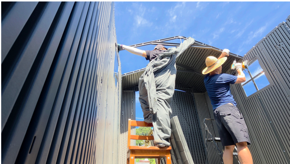
트러스트와 벽체, 지붕패널을 동시에 잡고 연결해주는 작업
